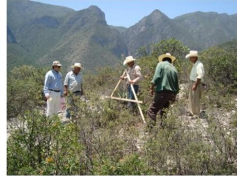
Trazo de curvas a nivel para la ubicación de tinas ciegas y zanjas bordo.
